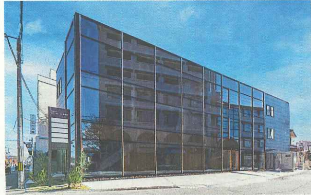
向日市の木造オフィスビル。カーテンウォールと内側にはMOCROSSを組み合わせた
